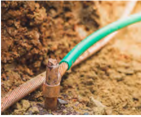
▲ Görsel 3.8: İletken topraklama kablosunun topraklama çubuğuna kaynaklanması
