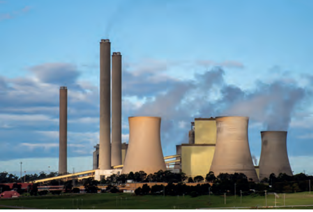
Görsel 2.12: Nükleer enerji santrali
