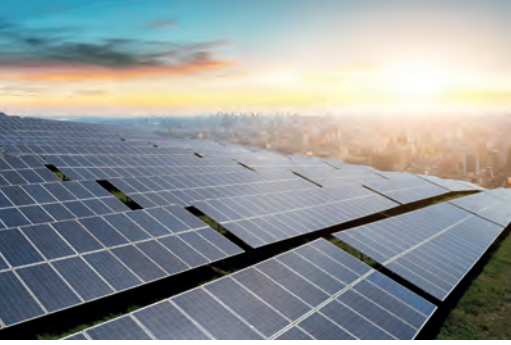
Görsel 2.15: Çatı güneş panelleri
