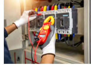
Bir elektrik panosu
