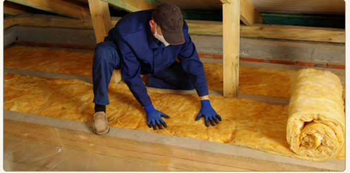
Görsel 1.3: Binanın çatı katına yapılan ısı yalıtımı
