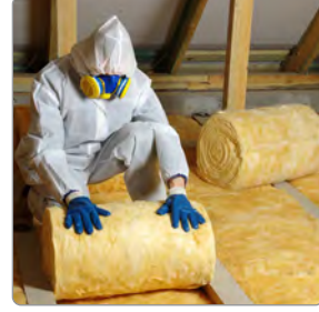
Görsel 4.25: Çatı içi cam yünü uygulaması
