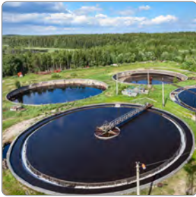
Görsel 3.10: Atık su temizleme tesisi
